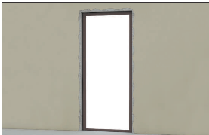
Установите дверную коробку (раму) в проем.
