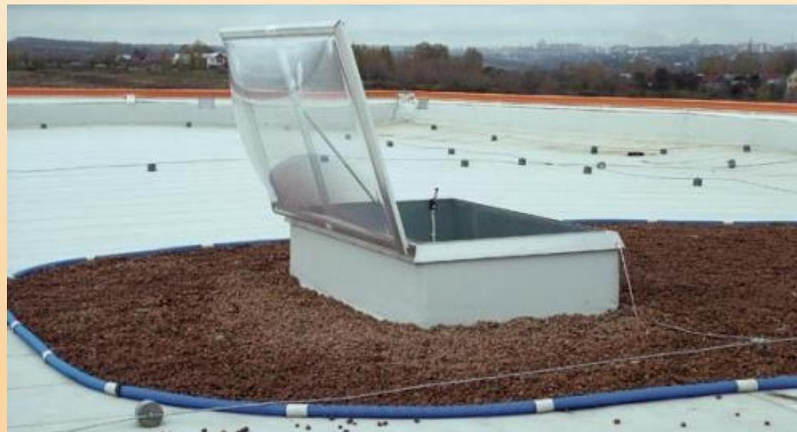
На кровле современных коммерческих объектов устраивается большое количество зенитных фонарей и люков дымоудаления, общая площадь которых может достигать до 30% от площади кровли.
