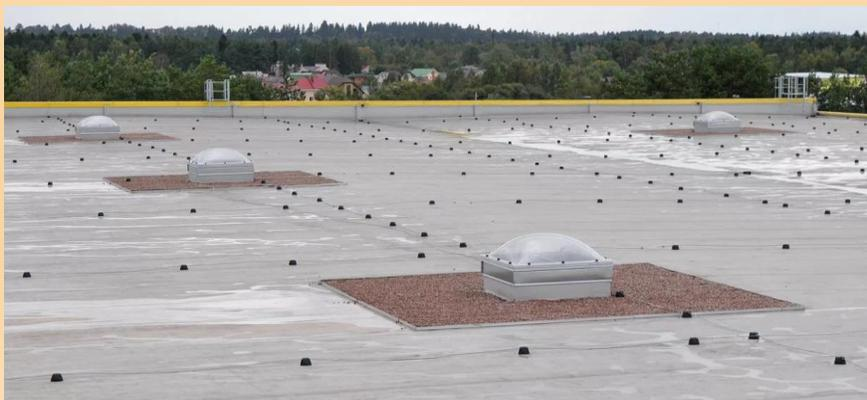
**Традиционные варианты устройства противопожарных рассечек на кровле и люков дымоудаления при помощи гравийной отсыпки.** Люки дымоудаления монтируются на крышах зданий и при возникновении пожара автоматически открываются. В качестве таких люков могут использоваться зенитные фонари, которые при нормальных условиях выполняют функции освещения и вентилирования.
