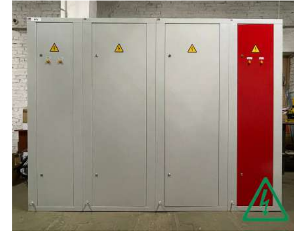
2022 ГРЩ Склад Бакалеи
