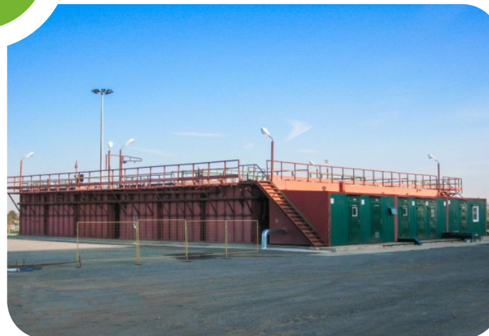
Станция очистки бытовых сточных вод 1000 м 3 /сут для логистического комплекса
