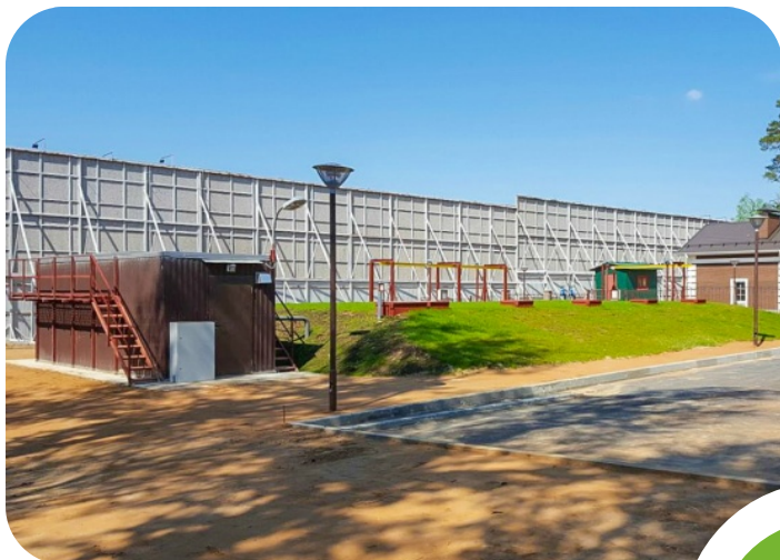
Станция очистки ливневых сточных вод для коттеджного поселка
