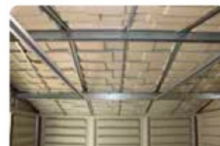
Стены, двери и крыша армированы металлом
