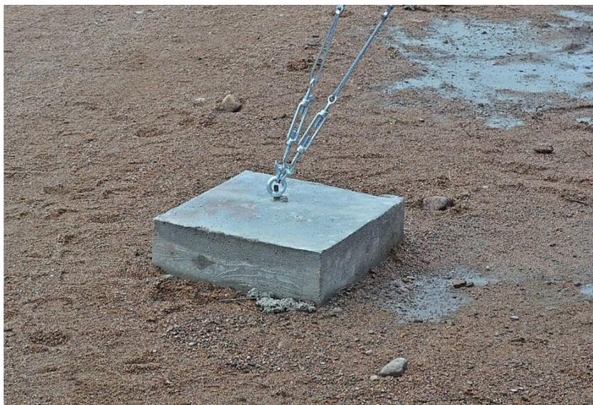
Рисунок 9 – Узлы крепления такелажа для растяжки мачты ВГ.
