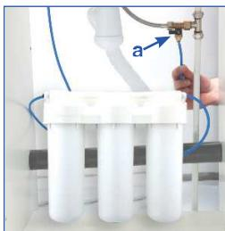
**13.** Удалите стопорную клипсу, вставьте трубку (а) в урет, подталкивая до упора. Установите клипсу на место. Для разметки отверстий крепления водоочистителя можно воспользоваться графическим отверстием на крышке кассетки.
