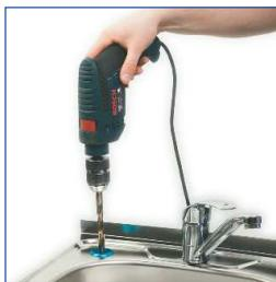
**5.** В выбранном вами месте для крана чистой воды просверлите отверстие диаметром 12 мм
