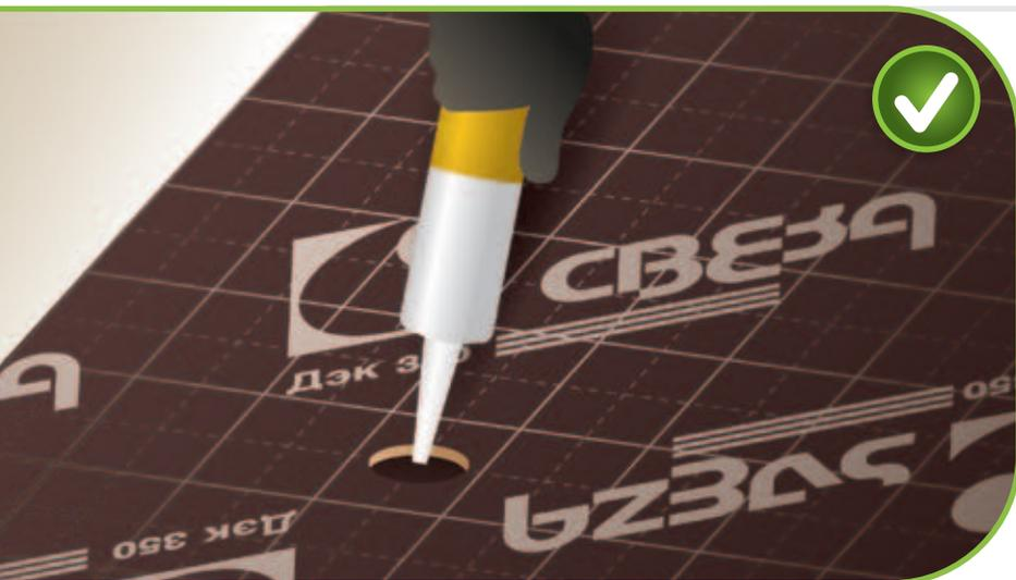
Все отверстия, сделанные в ходе монтажных работ, заполните силиконовым клеем, чтобы предотвратить попадание влаги (набухания).
