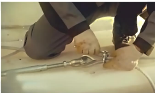
Рисунок 4. Заделка троса
