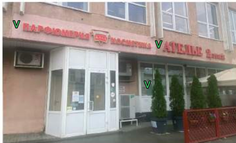
ул. Коммунальная, 21А
