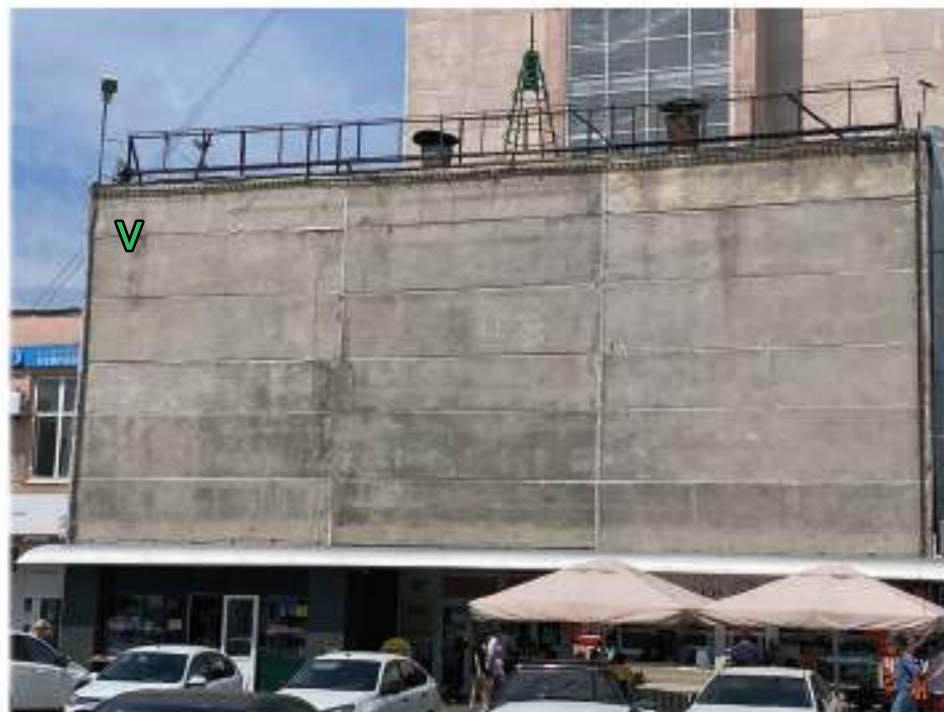
ул. Коммунальная, 21А
