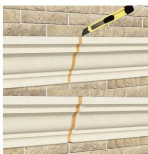
5. Срезаем лишний клей, углубляем V-образно стык
