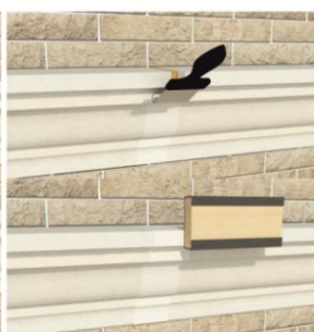
6. Зашпаклевываем и шкурим место стыка
