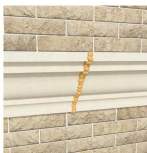
4. Заполняем стык полиуретановым клеем
