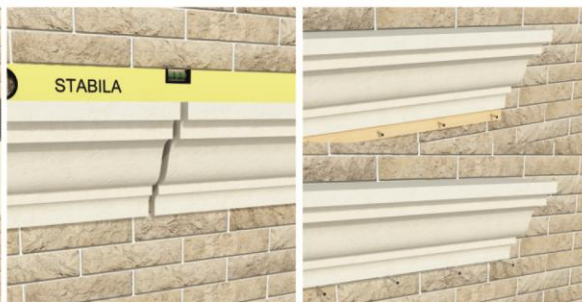
3. Проверка уровня и фиксация
