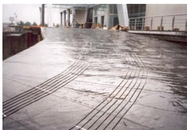
При установке системы снеготаяния под тротуарную плитку (ФЭМ — фигурные элементы мощения) нужно быть особенно осторожными, чтобы не повредить нагревательный кабель. Поверхность, на которую будут укладывать кабель, должна быть ровной, без углублений, свободной от камней или других острых предметов. Нагревательные кабели устанавливают под песчаной подушкой на глубину 2–3 см.
