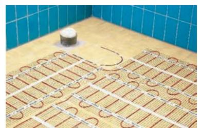
4. Залить разложенный мат плиточным клеем (без воздушных карманов) и уложить плитку.
