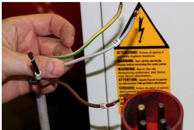
Подключение компрессора к электросети
