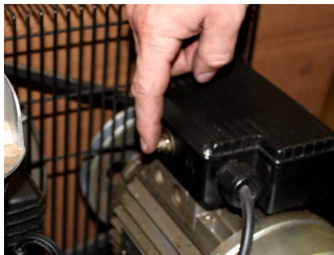
Срабатывание тепловой защиты предупреждает о проблемах в электросети
