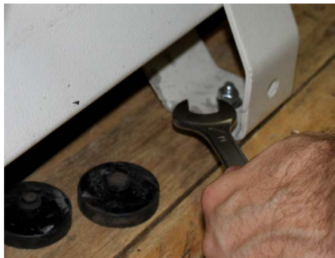
Установка компрессора на виброопоры
