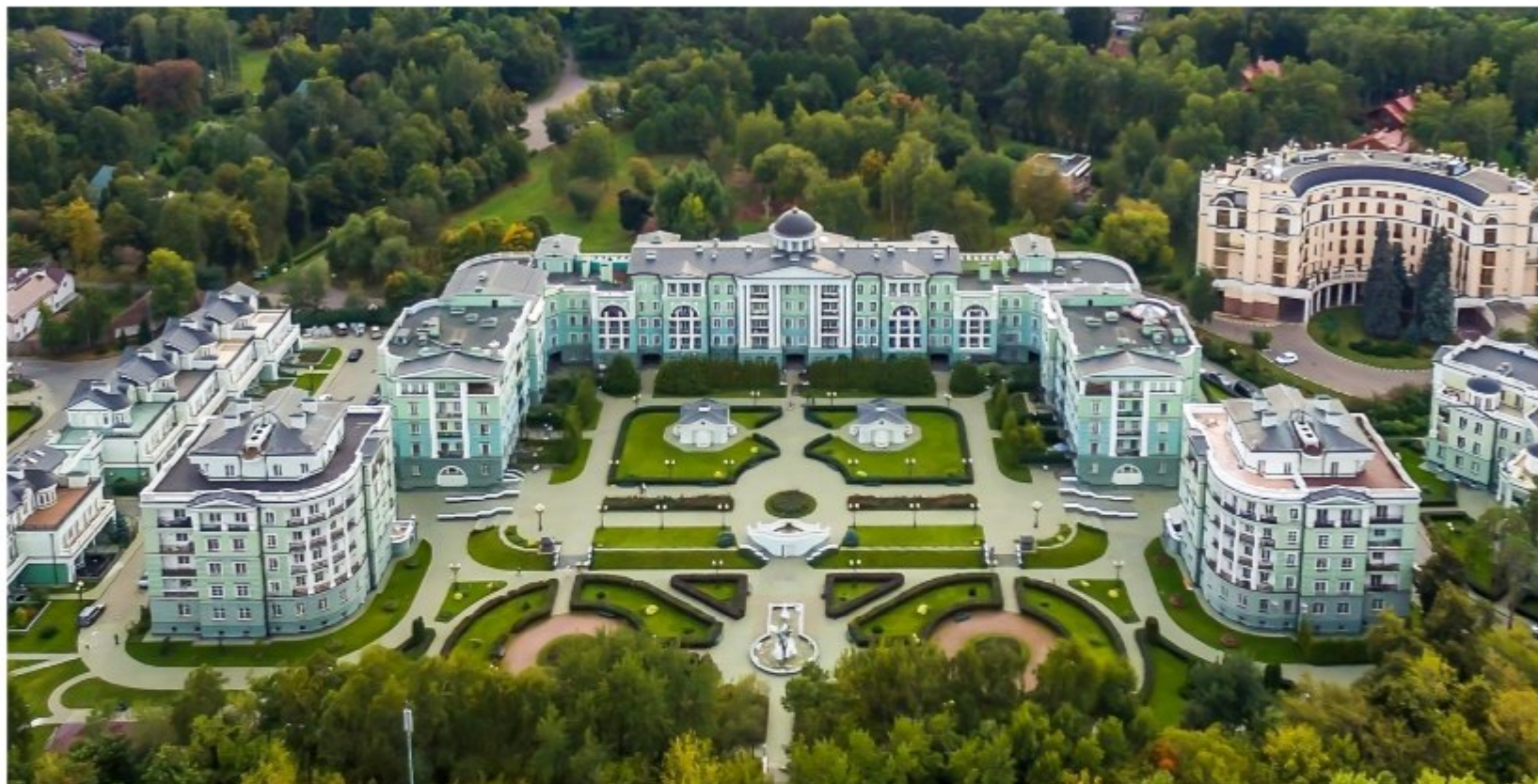
г. Москва, Покровское-Стрешнево, ул. Береговая, 8
